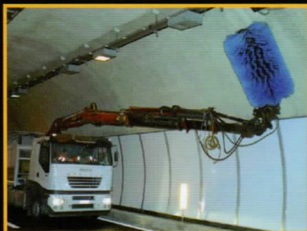
Rotolavaggio dei piedritti e delle volte verniciate con pitture "ceramizzanti".
